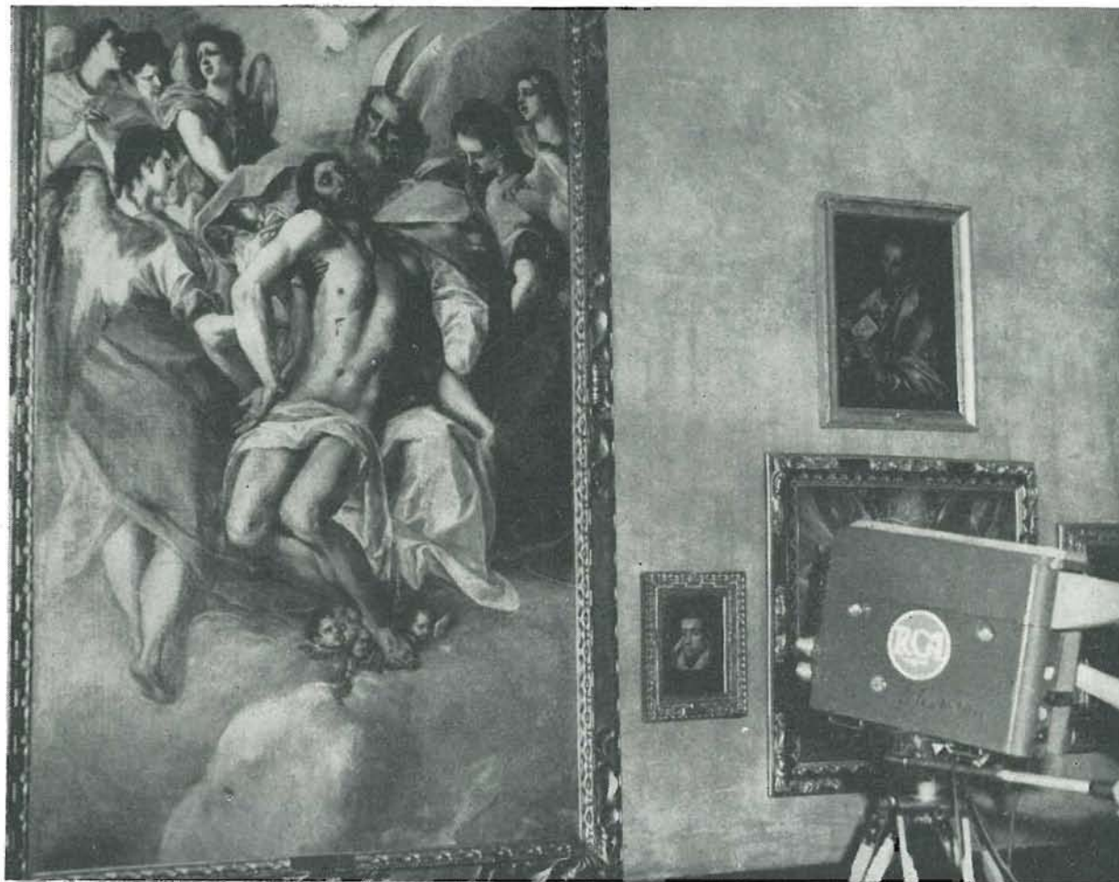
Fig. 1.2. - Nella telecamera vi è un tubo a raggi catodici, nel cui interno l'obiettivo proietta l'immagine luminosa del quadro. In esso i chiaroscuri dell'immagine vengono tradotti in modulazione elettrica, la quale viene trasferita agli apparecchi riceventi di televisione mediante onde radio ultracorte.
